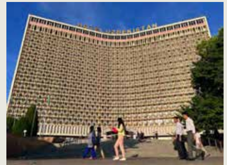
فندق أوزباكستان، أيقونة العمارة الوحشية السوفيتية. اكتمل بناؤه في عام 1974م، ويُعتبر أكبر فندق في العاصمة طشقند. يضم 254 غرفة، ويبلغ ارتفاعه 17 طابقاً.
