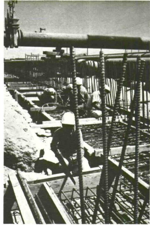
يبنى حول كل اثنين أو ثلاثة خزانات جدار من الاسمنت يحول دون انتشار الزيت الى بقية الخزانات في الحالات الطارئة .
