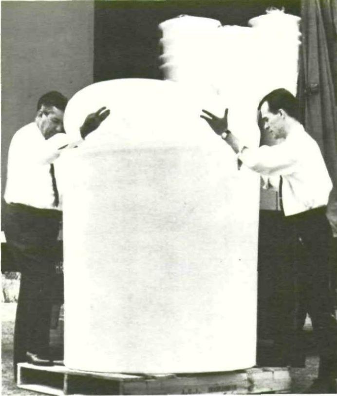
تصنع هذه الأوعية الضخمة من مسحوق البوليثيلين، وهي تستعمل لأغراض متعددة.
