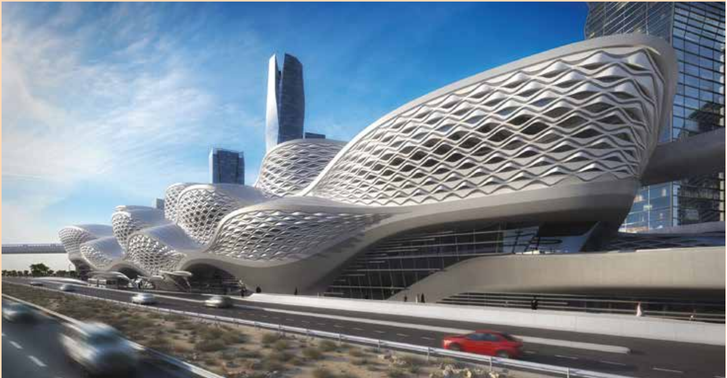
محطة مترو الرياض بالمركز المالي
