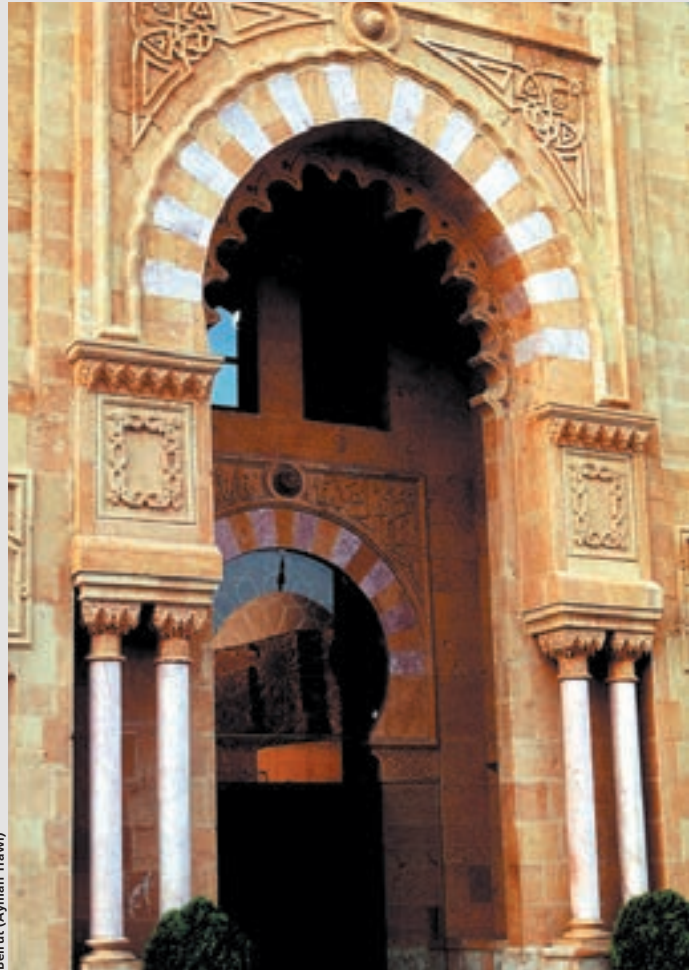
الزخرفة العثمانية على واجهة مبنى البلدية ببيروت
