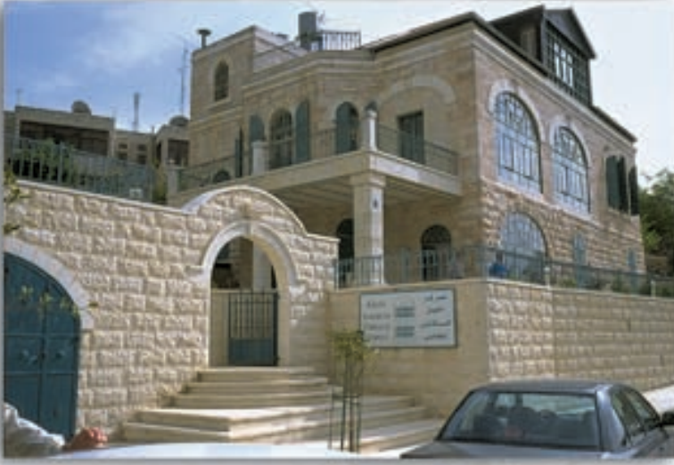
مركز خليل السكاكيني الثقافي في رام الله، وهذه «القبلا» هي أحد مبنيين قديمين قامت منظمة (رواق) بترميمهما وتجهيزهما للاستخدام كمركزين ثقافيين. والمبنى الآخر هو مركز «بلدنا الثقافي»
