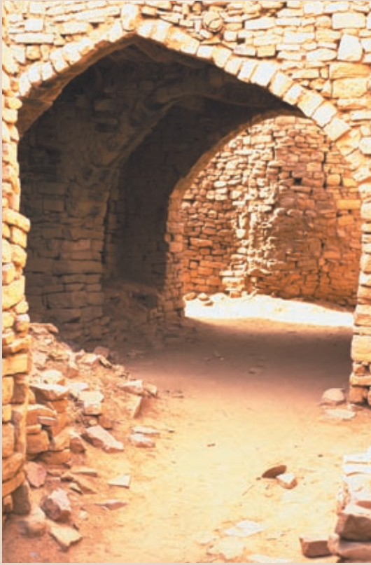
تم إعادة ترميم العديد من الشوارع المغطاة بالأقواس في مدينة دومة الجندل العتيقة المبنية بالطوب
