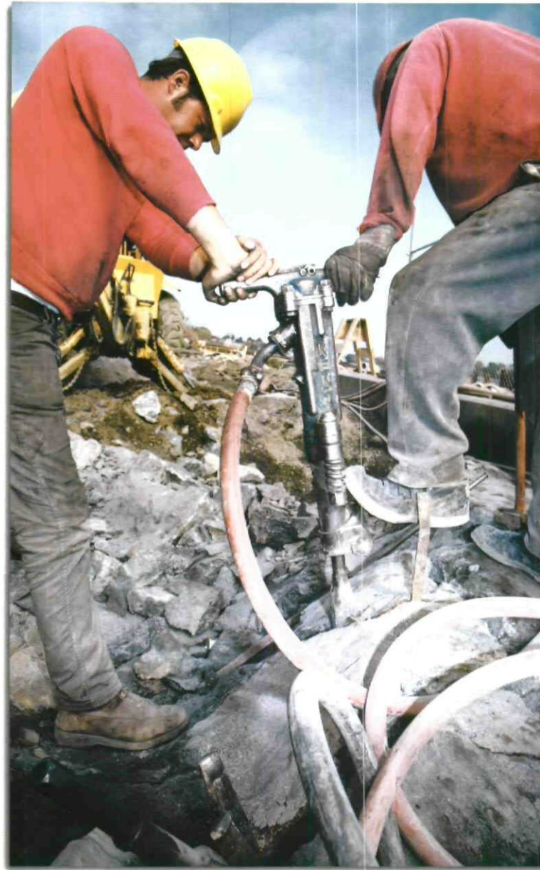
عمليات الحفر والبناء المسحوبة بالضجيج العالي، أصبحت سمة من سمات الحياة
