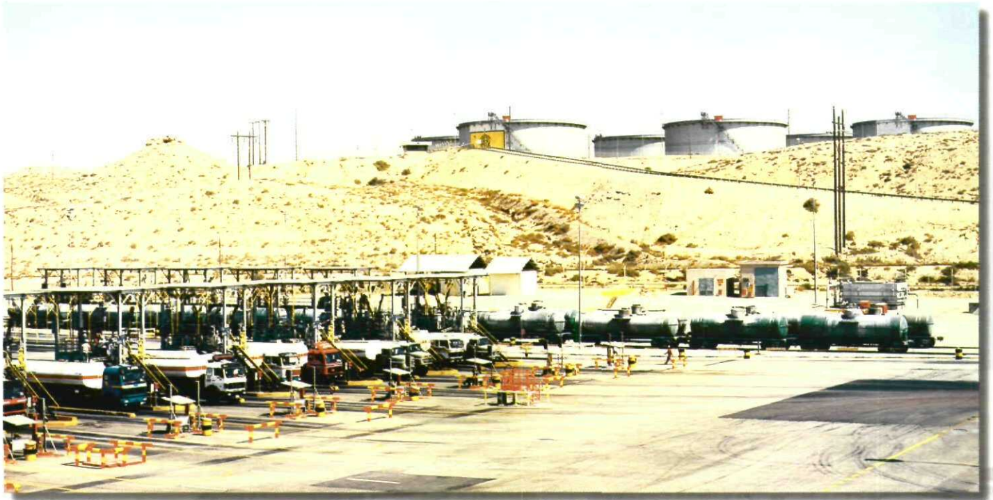
تعد محطة التوزيع الرئيسية في الظهران، نقطة انطلاق خط أنابيب المنتجات البترولية الذي يشق الصحراء صوب الرياض فالقصيم.
