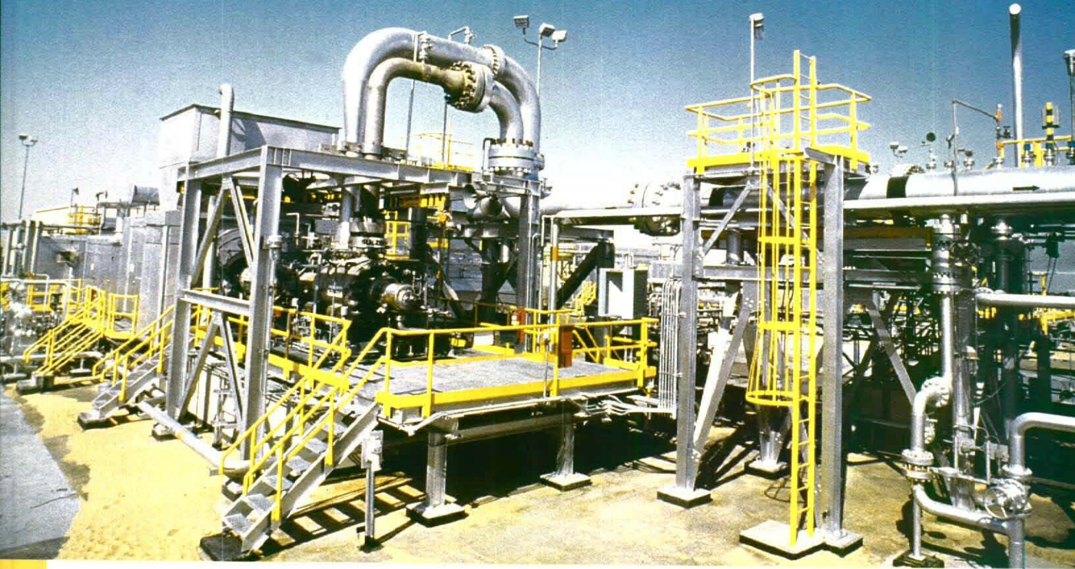
تمثل مرافق المحطة المركزية لحقن الماء بالحوية أحد عناصر إدارة المكامن في أرامكو السعودية، وهي تقوم بضخ ماء البحر - بعد معالجته - إلى آبار الحقن البعيدة الموجودة في حقل الغوار الجنوبي.
