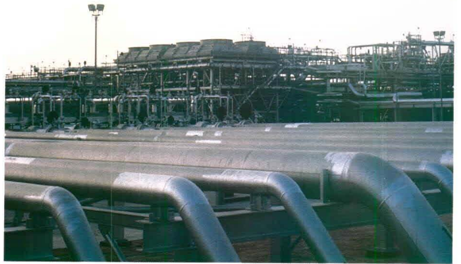
أنابيب السحب التي تنقل الزيت الخام والغاز المرافق له إلى معمل حرص رقم (١) لفرز الغاز من الزيت.
