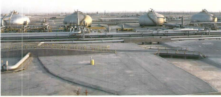
تقوم هذه الخزانات الكروية في بقيق بمعالجة الغاز المنتج من منطقة الأعمال الجنوبية التابعة لأرامكو السعودية، ويتم ضخ سوائل الغاز الطبيعي المعالجة في بقيق إلى رأس تنورة لإجراء عمليات التحزنة لها.
