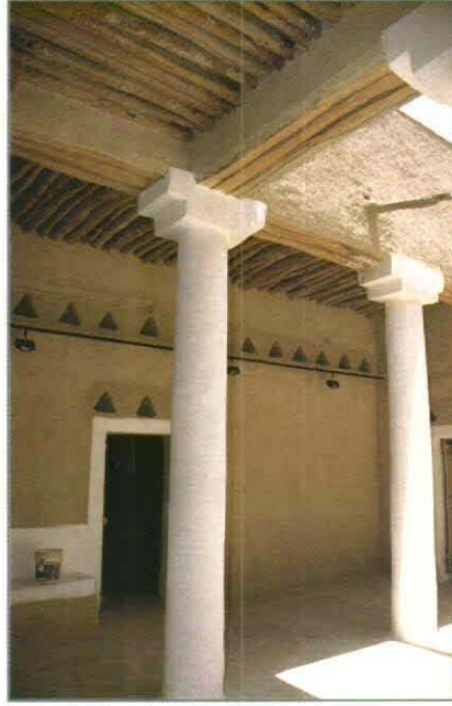
فناء داخلي في قصر المصمك تبدو فيه الأعمدة الحجرية، والسقوف الخشبية والأروقة المفتوحة لدخول الضوء الطبيعي.
