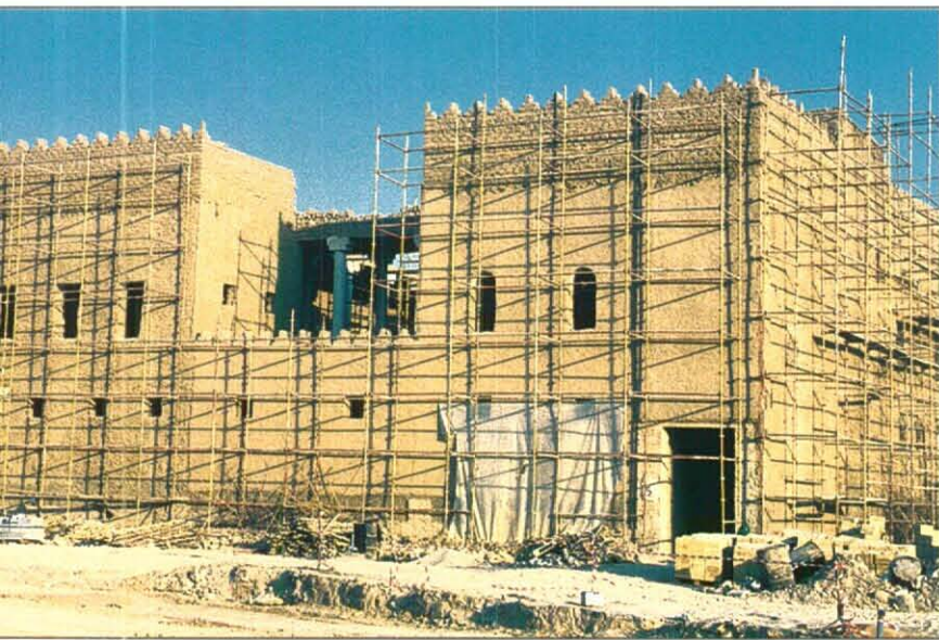
أعمال الترميم والبناء في جانب من مركز الملك عبدالعزيز التاريخي بالرياض.
