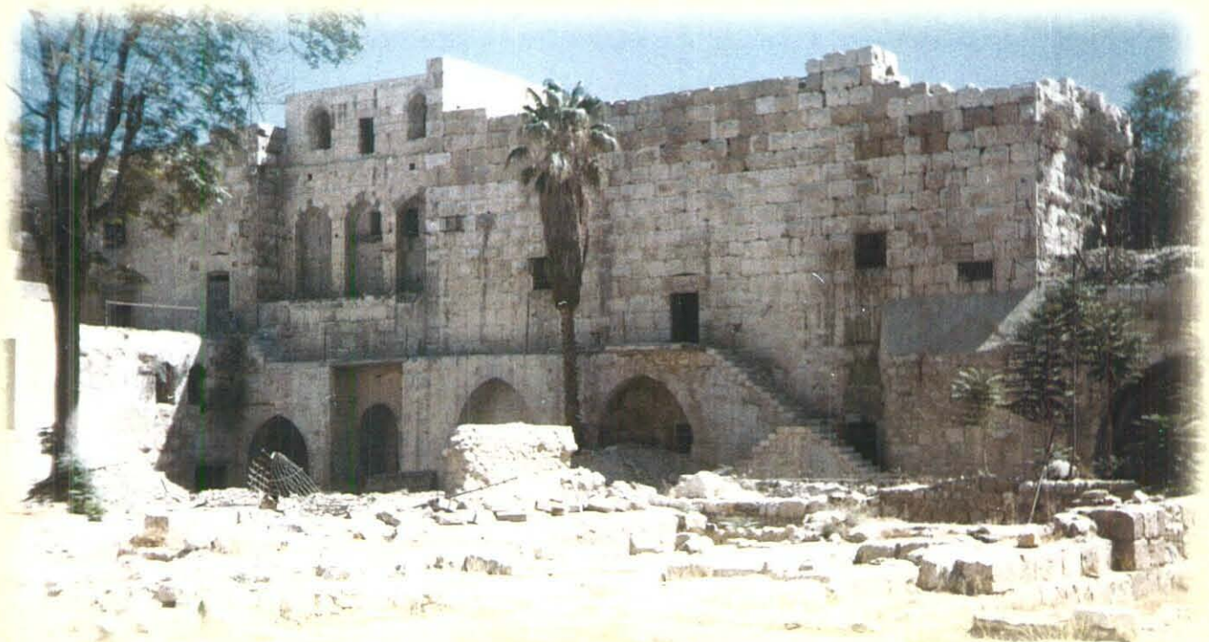
مشهد داخلي لقلعة دمشق التي يوشح فيها بأعمال الترميم والإصلاح .
