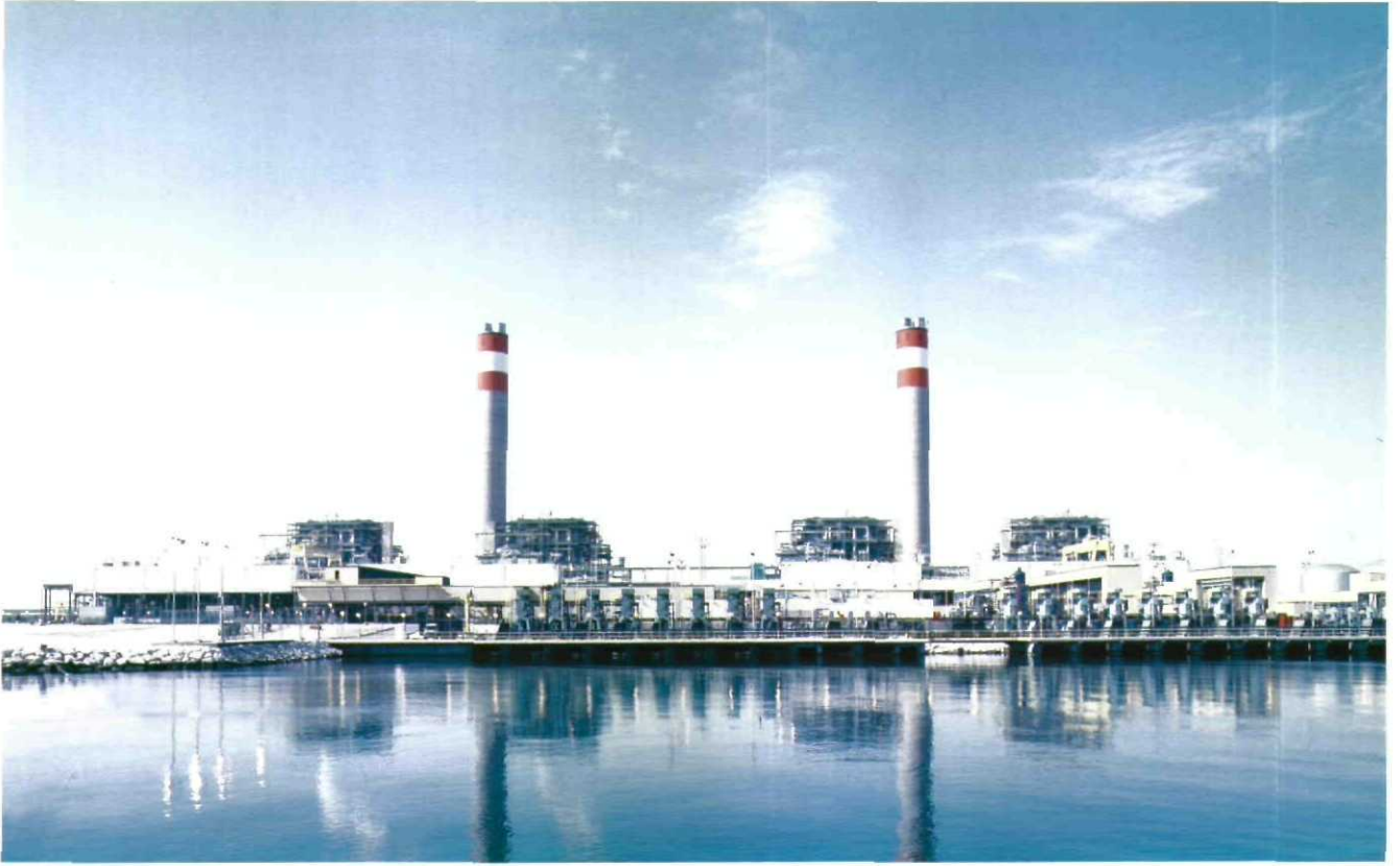
محطة القرية البخارية العملاقة لتوليد الكهرباء على ساحل الخليج العربي، التي تعتمد في تشغيلها على الزيت والغاز معاً.
