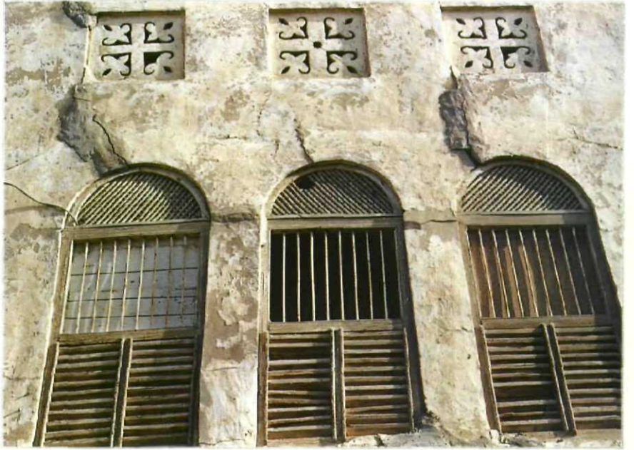
تكوين جمالي لأحد المساكن بالهفوف، حيث تظل نوافذ المجلس على السكة الرئيسة تعدها الرواشن التي تضيئ منظرًا جمالياً على المنزل وتعمل على تهويته.
