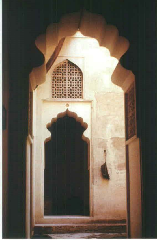
● تحتفظ الجدران والأسقف بالبرودة طيلة المساء، لتبقيها داخل المبنى حين تشتد حرارة الشمس في النهار.
