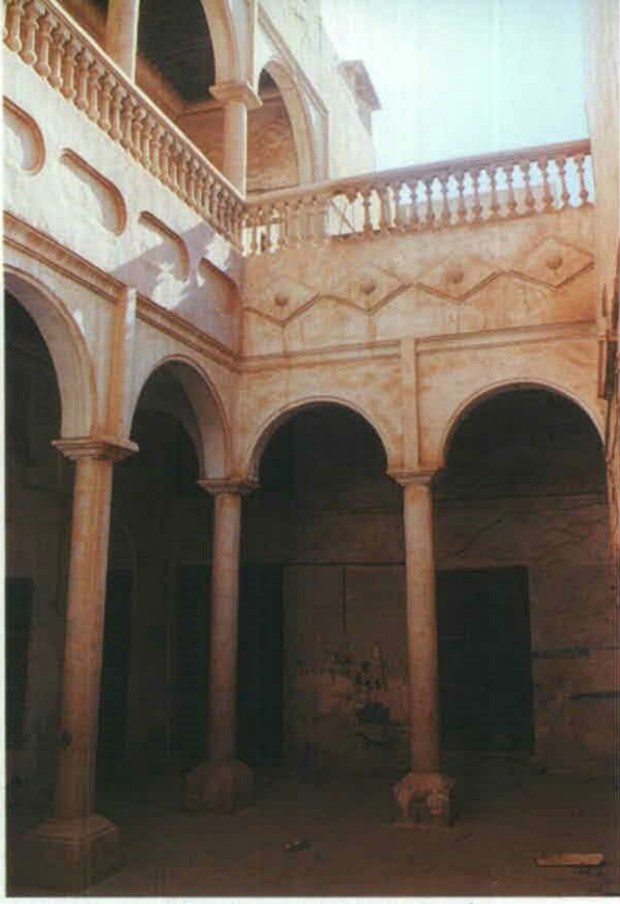
● فناء داخلي في أحد المباني التقليدية بمدينة الهفوف كان يحقق وظائف مناخية واجتماعية للسكان في تلك الفترة، وهذا يكاد ينقرض اليوم .
