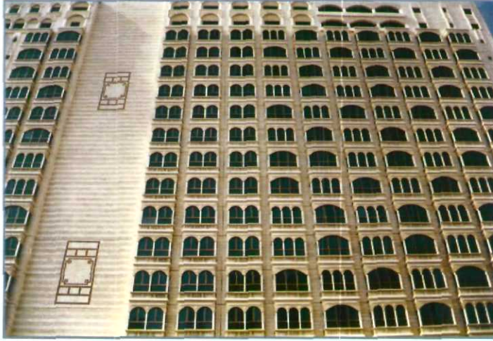
تراجيح بين الشكلين التقليدي والمعاصر في احد المباني الحديثة في مكة المكرمة
