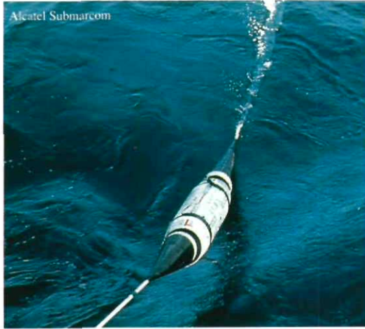
صورة للمضخة الإلكترونية للإشارة الضوئية في الكابل البحري.
