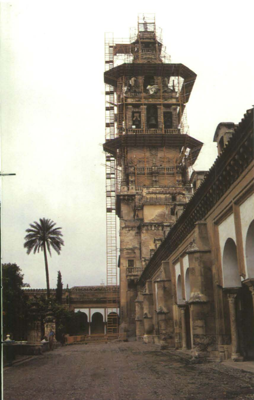
برج النواقيس تحت الترميم وتبدو الى اليسار أطراف فناء البرتقال .
