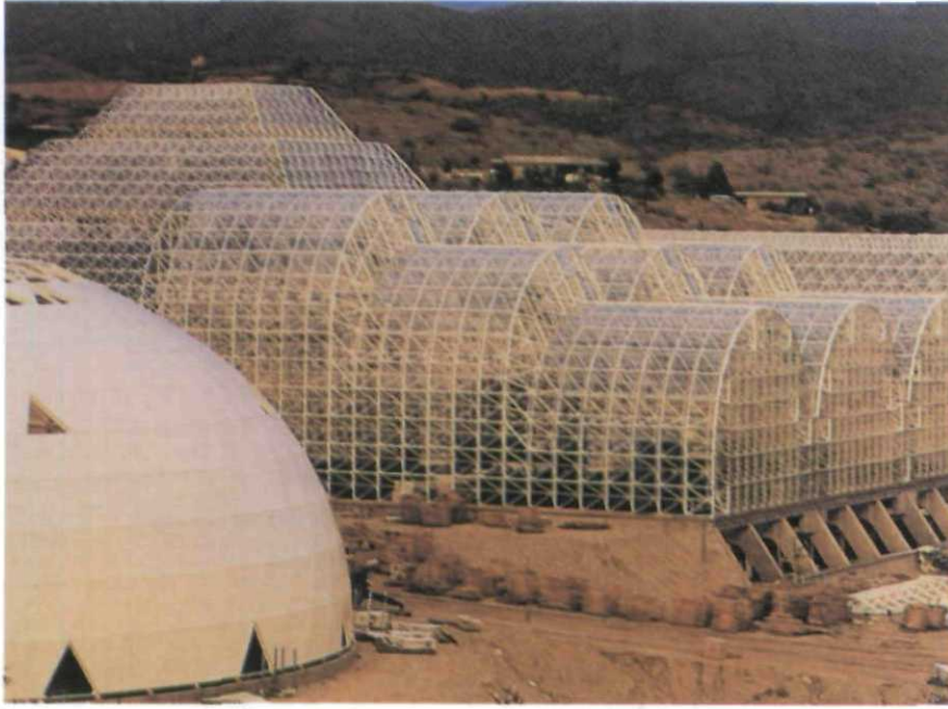
هذا المنشأ المعدني العملاق المعزول تماماً عن العالم .. هو مقر تجربة « الأرض الثانية » .
