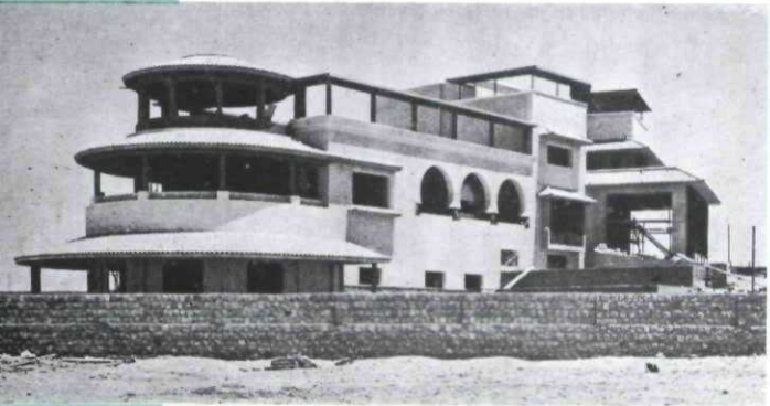
احدى القيلات الانيقة المبنية على احدث طراز . وقد اخذ هذا الطراز من البناء ينتشر بكثرة في الرياض .
