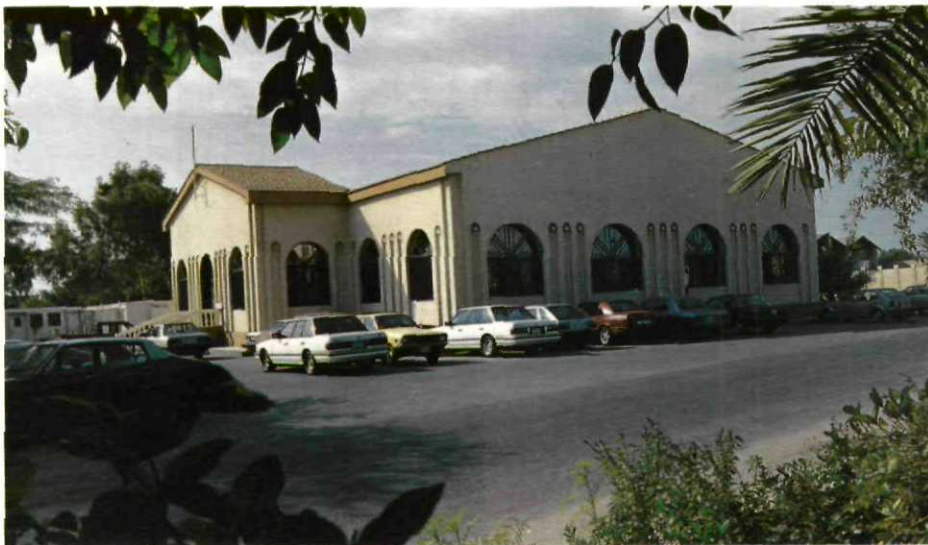
مبنى المركز بالرفاع الغربي .
