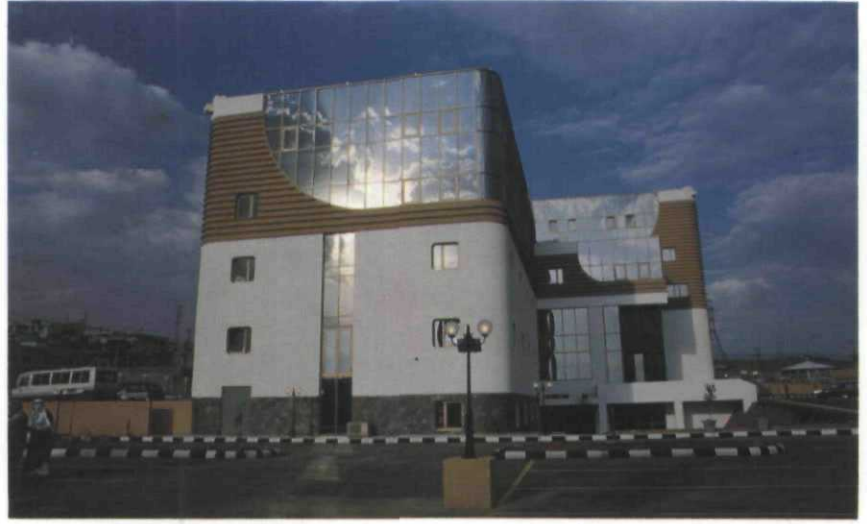
مبنى الغرفة التجارية الصناعية بأبها ، وهو يمثل الطراز المعماري الحديث المتصل بالرونق المعماري التقليدي .
