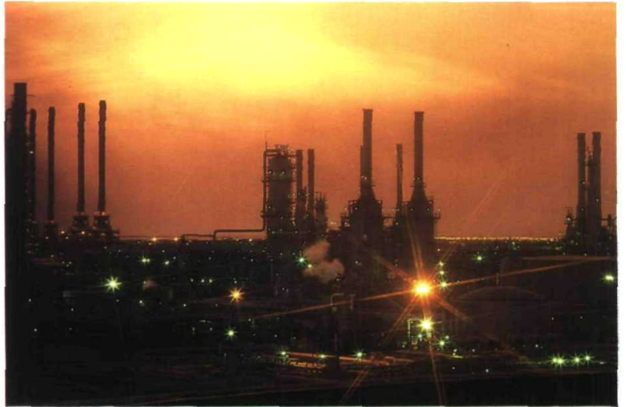
الأسوار المتألثة والأبراج الشاهقة هي أكثر ما يميز المشهد الليلي لمعمل التكرير في رأس تنورة . ويظهر في مقدمة الصورة وحدة معالجة المخلفات ، بينما يظهر في مؤخرتها المهدبات الرنيومية ووحدة تقطير الحام التي تصل طاقتها الى ٢٥٠.٠٠٠ برميل في اليوم .
