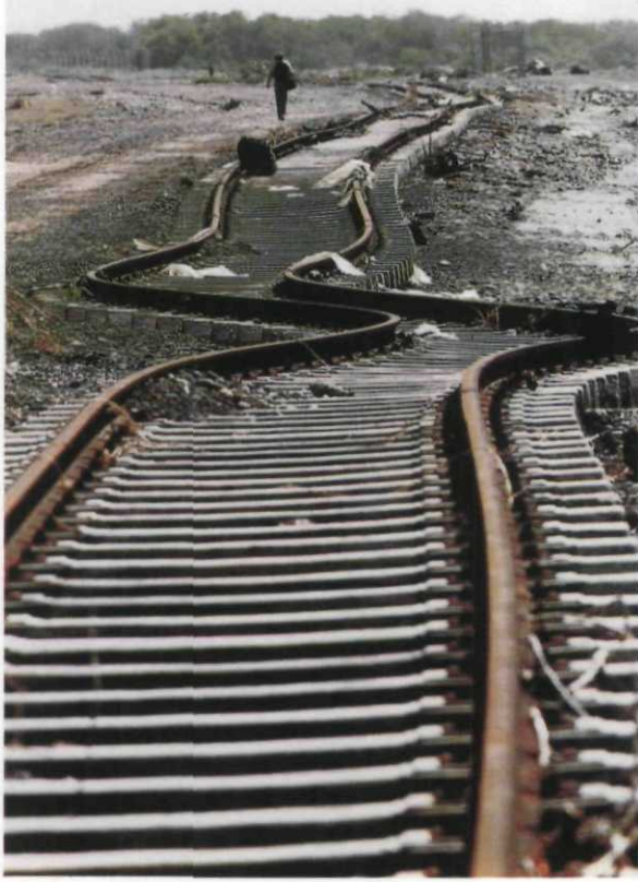
سكة حديد انخرقت بسبب الزلزال .
