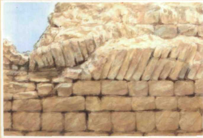
الريمان اعلاه عقود (فوق) تحيط بالمخازن المجاورة لضريح الملك رمسيس الثاني (القرن الثالث عشر ق.م) وهي مبنية بقطع من الطوب المائل (تحت).
