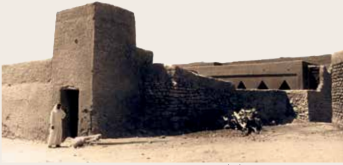
بحلول عام 1380 هـ (1960م) بدأت أعمال إعادة بناء بعض البيوت والمساجد في الظريف، باستخدام المواد الطينية والحجارة الناجمة عن تهدم الأبنية القديمة. (الصورة بعدسة المعماري حسن فتحي).
